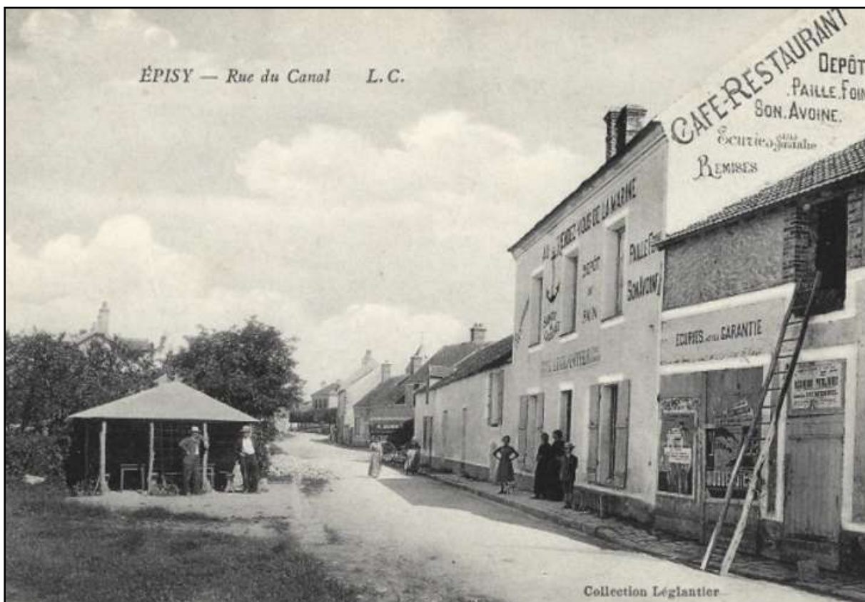
Fig. 9 : Épisy, rue du canal, carte postale, collection particulière. La maison POOLE-SMITH apparaît derrière les arbres sur la gauche.
